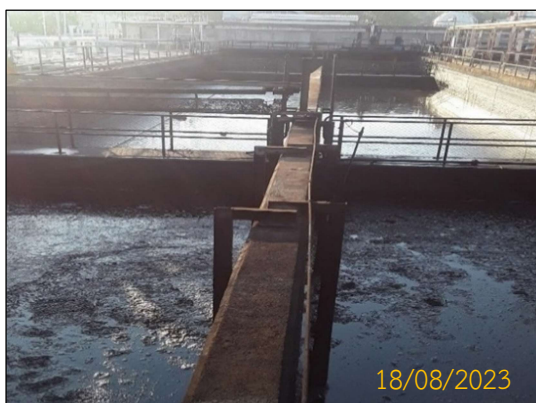
ภาพที่ 2.3-1 API Separator ที่สถานีผลิตลานกระบือ
